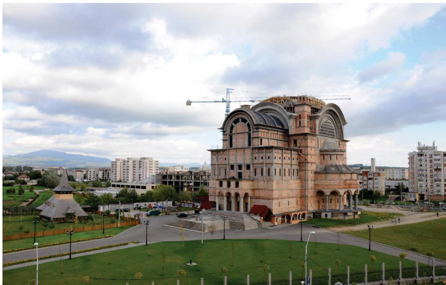
Lucrări executate în anul 2013
